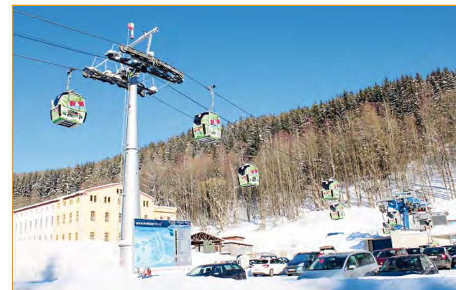
Podpěra č. 1 (původní podpěra č. 13 na Skalnátém plesu)
