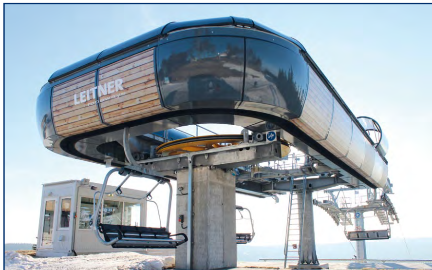
Horní vratná stanice lanovky Modes Grund
