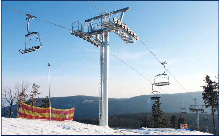
Poslední podpěra lanovky Pstruží – Plešivec
