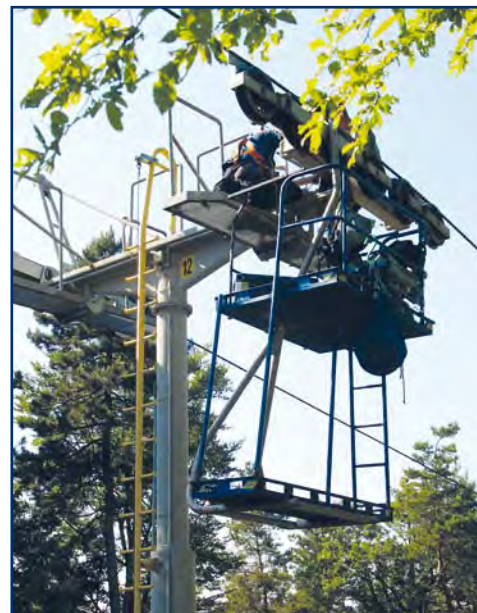
Údržba na trase lanovky
