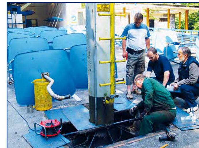
Defektoskopia oceľových konštrukcií – podpera č. 1
