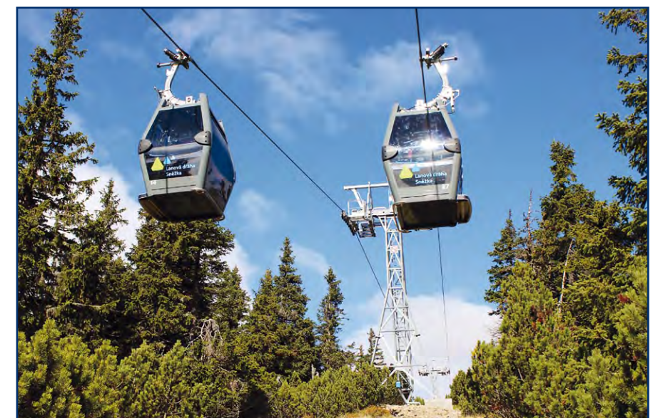
Podpěra č. 2 druhého úseku
