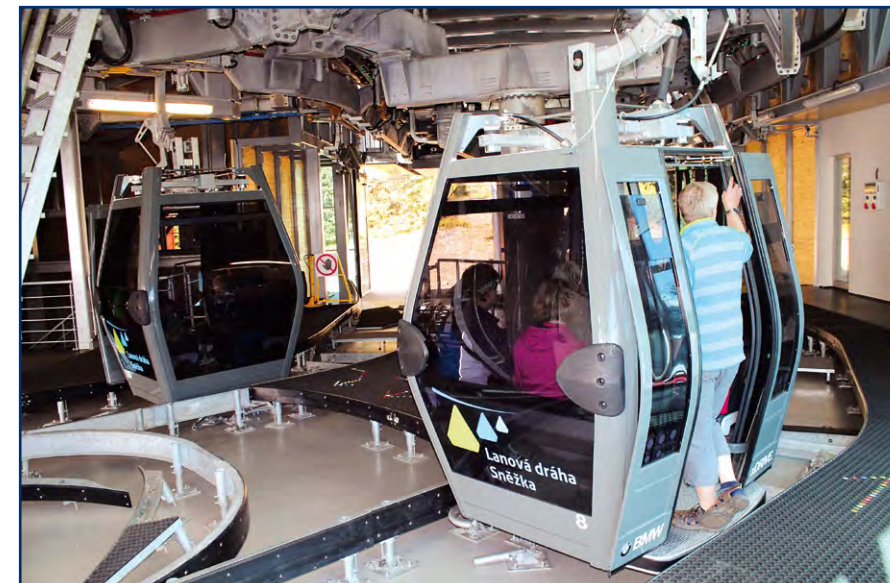
Interiér mezistanice na Růžové hoře
