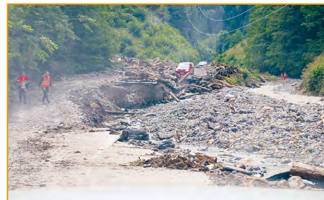
Prístupová cesta k lanovke a chate Vrátna
